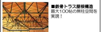
■鉄骨トラス屋根構造
