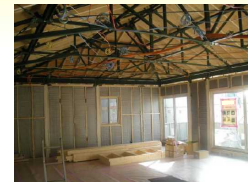
2階には柱の無い大空間 鉄骨トラス屋根構造
