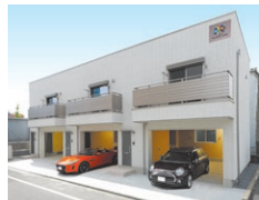
ガレージ付賃貸住宅 「プレミアムガレージハウス」
