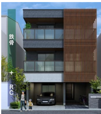
1階がRC造 上階が軽量鉄骨造のハイブリッド 重厚感のある外観を演出します
